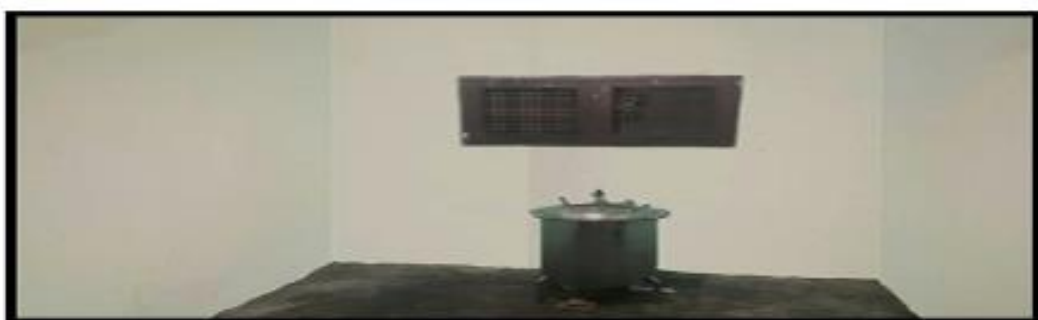
Gambar 4. Ruang Sesudah Direnovasi
