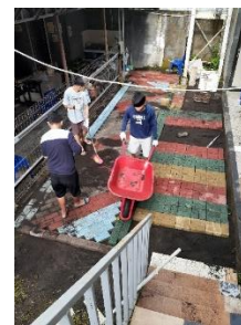
Pekerjaan finishing penghamparan pasir dan pemadatan
