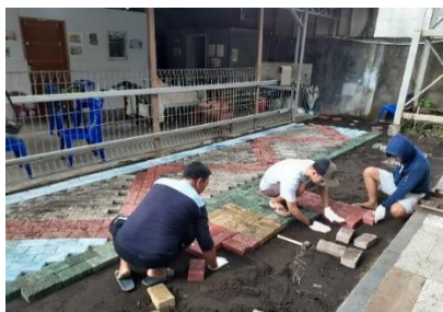
Pemasangan paving berpori oleh tim dibantu mahasiswa Jurusan Teknik Sipil
