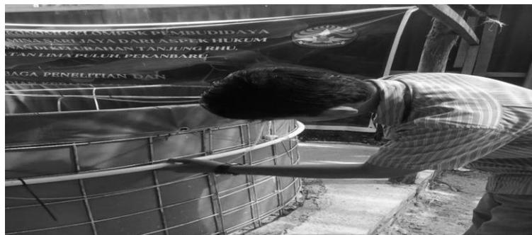
Gambar 7: Pemasangan pipa oksigen
