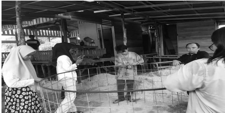
Gambar 3: Pengaitan besi dan pemasangan selang pelindung besi
