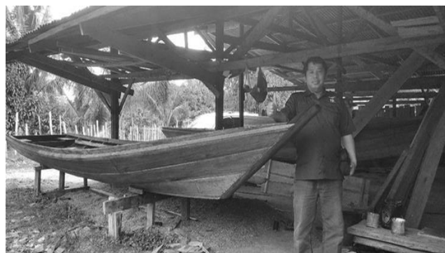
Gambar 2. Kondisi Eksisting Kapal Kayu (Sebelum Coating)
