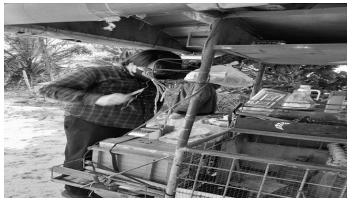
Gambar 8. Mahasiswa Jurusan Teknik Elektro Universitas Riau sedang memasang instalasi lampu LED
