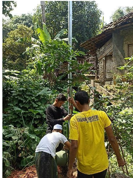
Gambar 3. Proses Pemasangan Tiang Lampu
