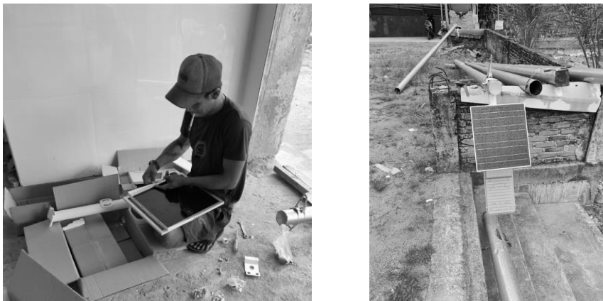
Gambar 7. Proses instalasi lampu PLTS di ground dan setelah terpasang di tiang lampu PJU sebelum kegiatan lapangan dilaksanakan
