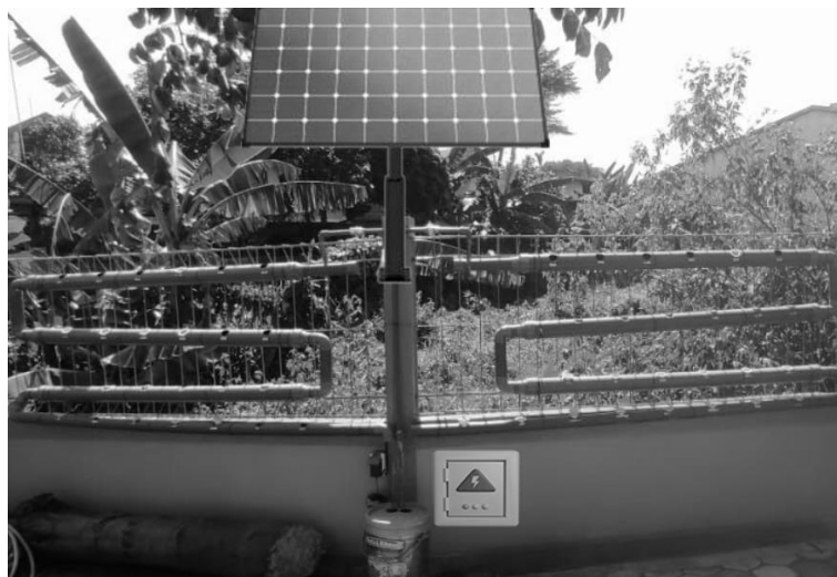
Gambar 2 : Panel surya pada instalasi hidroponik
