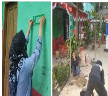
Gambar 5. Pemasangan jalur evakuasi & titik kumpul Sumber : Data primer
