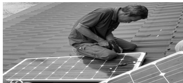
Gambar 4. Pemasangan panel surya
