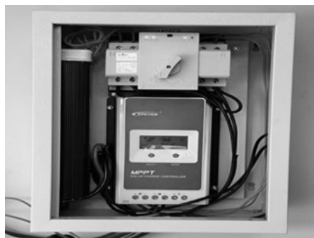
Gambar 5. Pemasangan SCC, Inverter, Dan ATS
