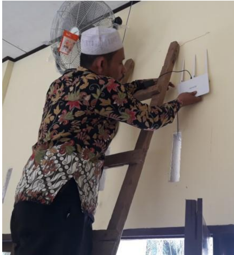
Gambar 8. pemasangan akses point untuk perluasan jangkauan layanan
