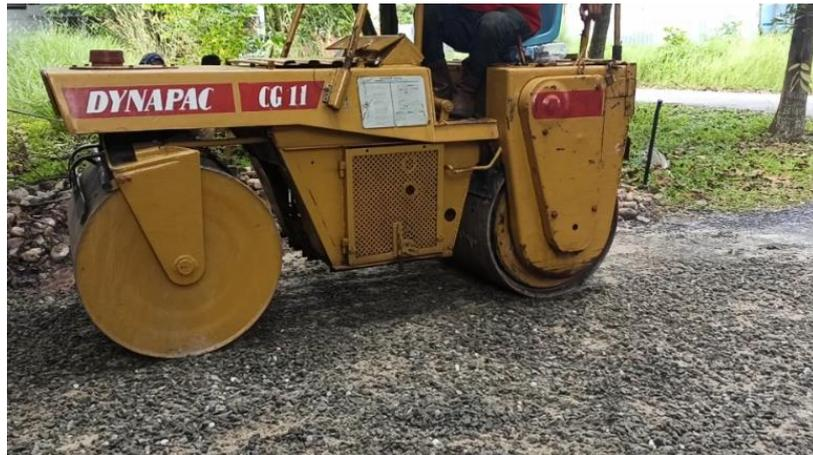
Gambar 4. Pemadatan Lapisan Base Sebelum Uji Gelar
