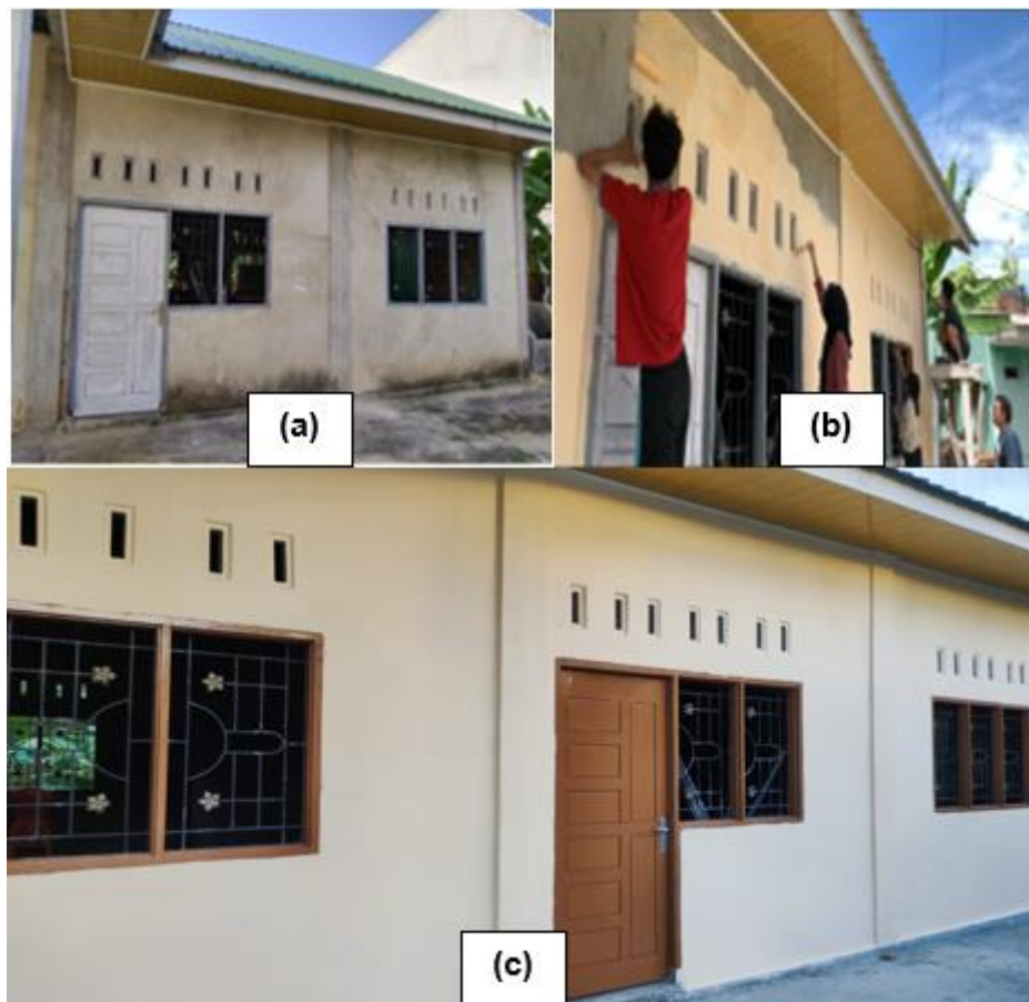
Gambar 5. Penampakan dinding luar ruang sebelum dilakukan finishing (a), Pekerjaan Plester dan pengecatan dinding luar (b), penampakan dinding luar yang sudah difinishing
